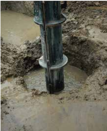
①掘削孔に装置挿入
