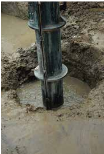
①掘削孔に装置挿入
